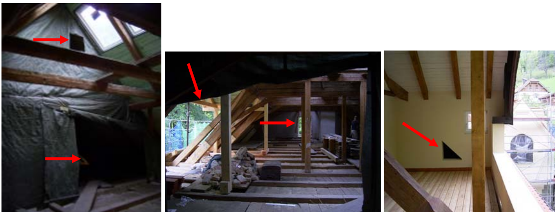
Abb. 5: Abgetrennter Fledermausbereich (linkes Bild) mit ständiger Durchflugsöffnung (oben) und nachts geöffnetem Bereich (unten), Zukünftiger Wohnbereich (mittleres Bild), vom Fledermausbereich aus gesehen, mit ursprünglicher Einflugsöffnung (hinten) und Öffnung für den vorgesehenen Balkon (links) sowie im Frühjahr 2004 zusätzlich geschaffene Einflugsöffnung auf dem Balkon (rechtes Bild).
