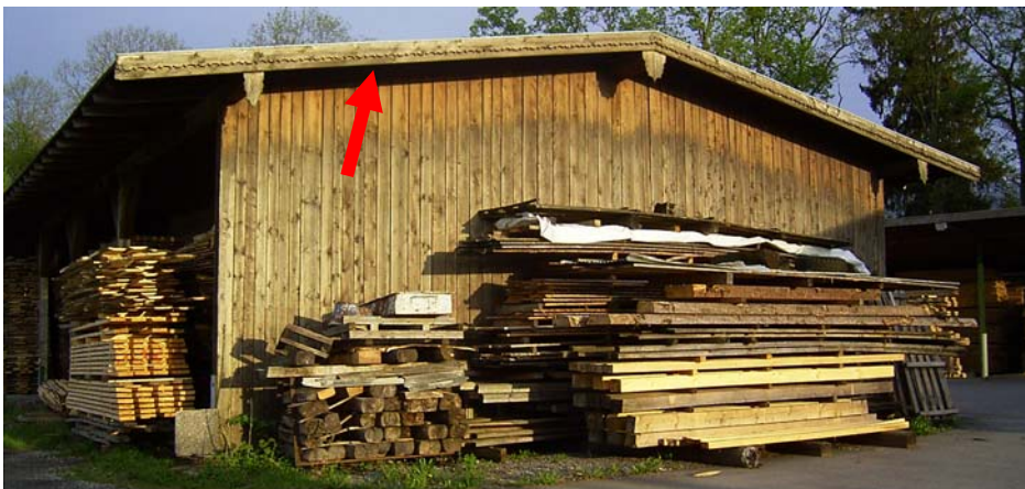
Abb. 8: Wochenstubenquartier der Rauhhautfledermaus. Der Pfeil weist auf den Spalt hinter dem Firstbrett mit den Hangplätzen der Tiere.
