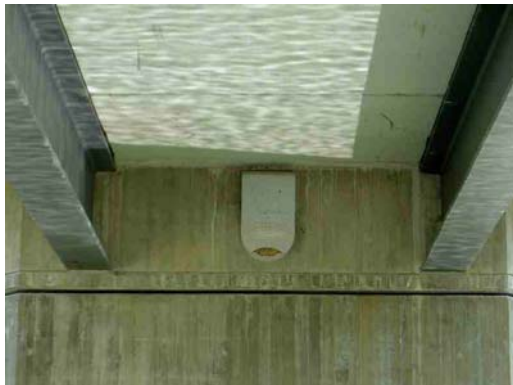
Abb. 6. Kasten unter der Loisachbrücke
