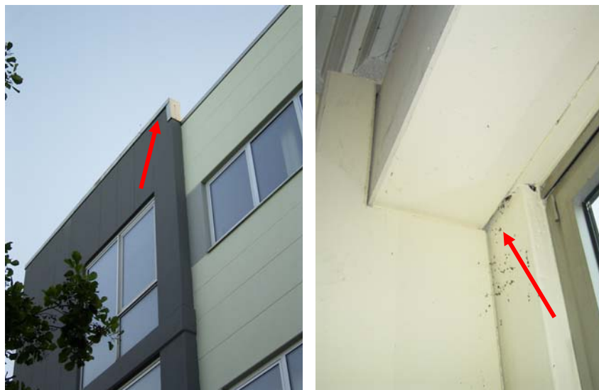
Abb. 6: Wochenstube der Weißrandfledermaus in Karlsfeld (DAH). Außenansicht (li.) und Blick auf den Hangplatz auf der Gebäudeinnenseite (re.).
